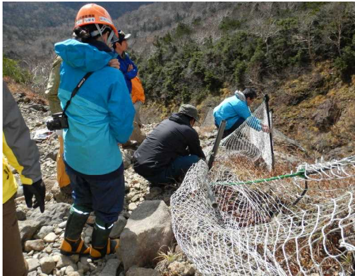
足下に気をつけて慎重に撤去作業中
