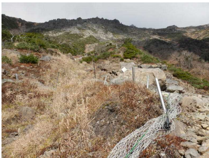
作業後、地面に下ろされた防護ネット
