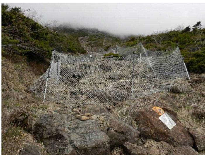
2時間ほどで設置完了！
