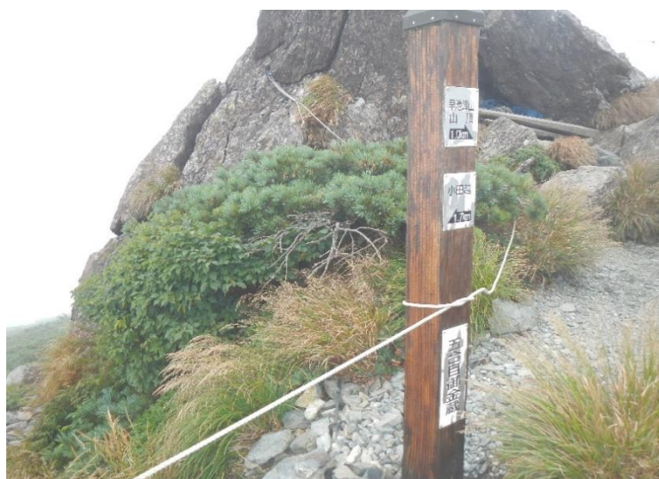
【防腐剤塗布後】
