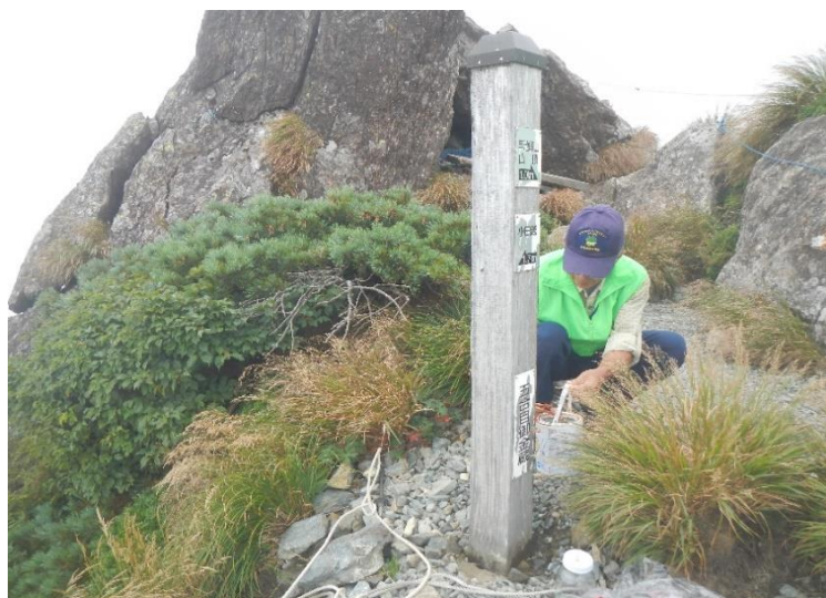
【防腐剤塗布前】
