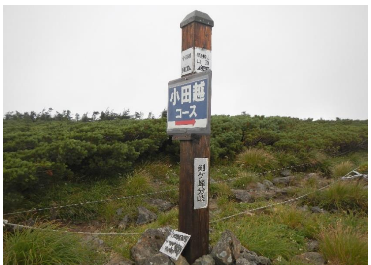
【防腐剤塗布後】
