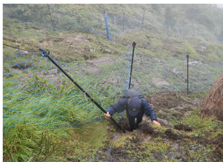
【傾いている支柱の補修】
