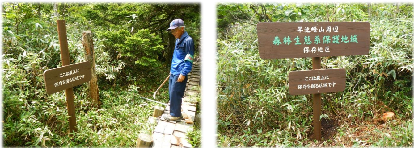
【薬師岳登山道入口付近に設置されていた老朽化した看板の交換作業】
