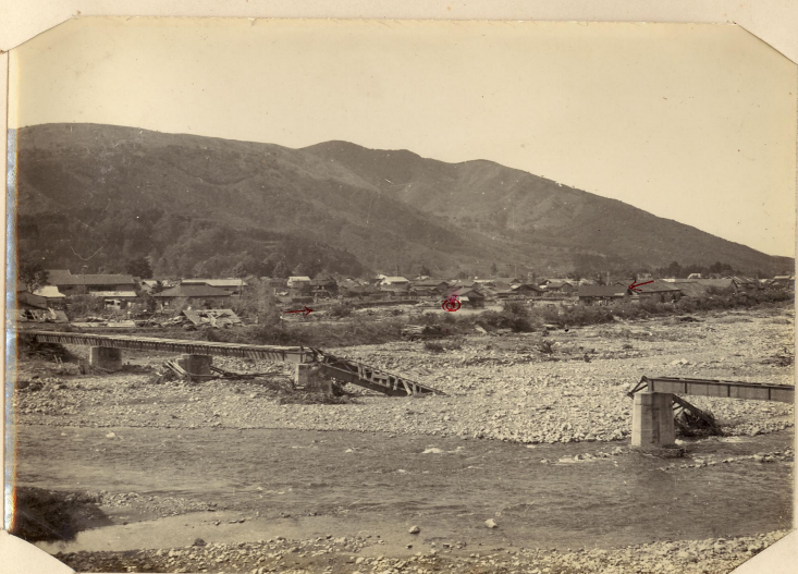
流出した森林鉄道の橋梁
