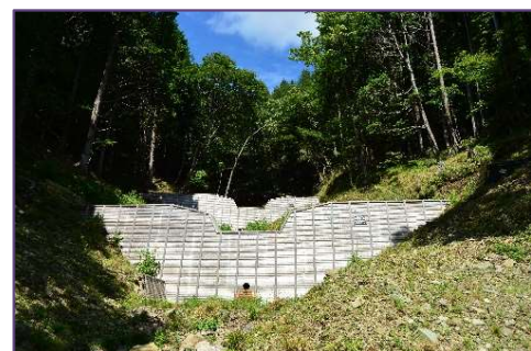
治山施設の整備
