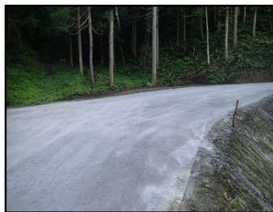
鉄鋼スラグによる簡易舗装
