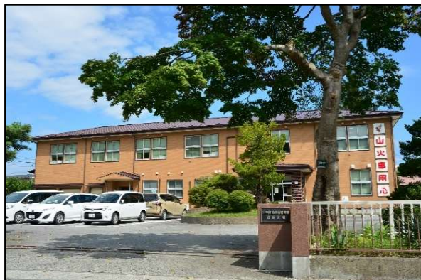
現在の庁舎 昭和51年11月15日 竣工 平成29年3月 耐震工事完了
