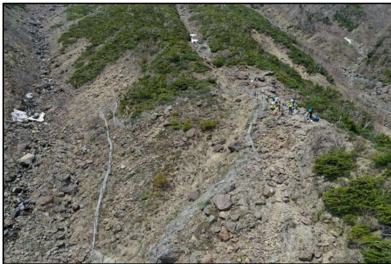
植生保護柵設置作業（令和4年5月空撮）
