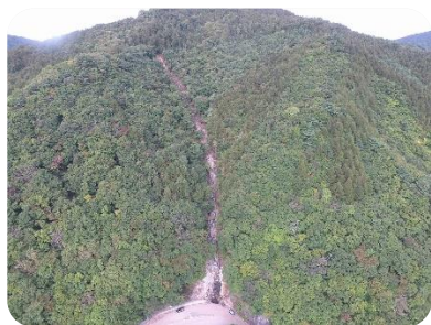
平成28年台風10号災害発災当時
