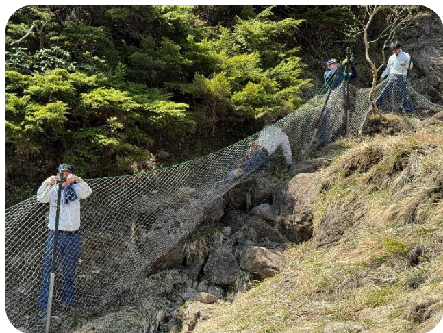
植生保護柵設置作業（令和8年5月設置）
