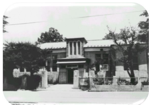
昭和12年に帝室林野局東京支局遠野出張所として新築された石倉町（現東館町）の庁舎。戦後は遠野営林署庁舎となり昭和51年に現庁舎が新築されるまで使用された。庁舎は現在よりも車道側にあった。正門左側のマツは今も青々としている。
