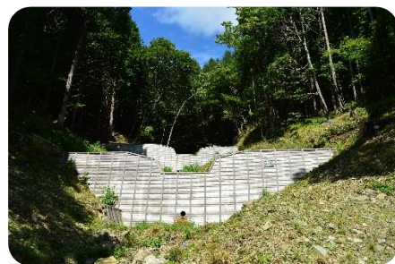
治山施設の整備
