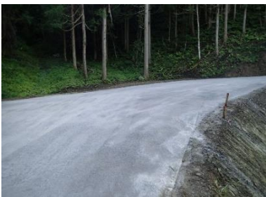
鉄鋼スラグによる簡易舗装
