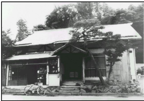
明治21年に開庁した遠野派出所の庁舎（砂場町） （現在の新町。自転車が配備されている。）
