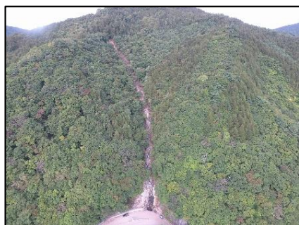
平成28年台風10号災害発災当時
