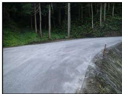
鉄鋼スラグによる簡易舗装
