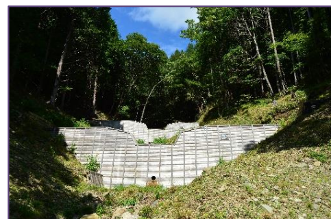
治山施設の整備
