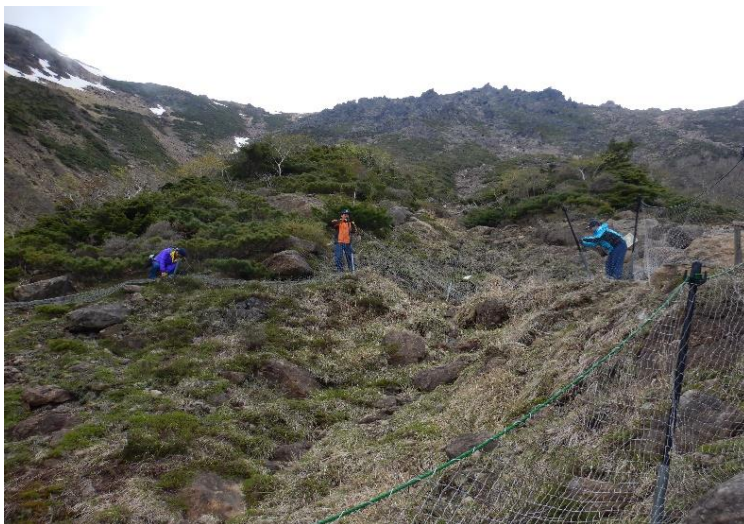
植生保護柵設置作業（令和7年5月空撮）
