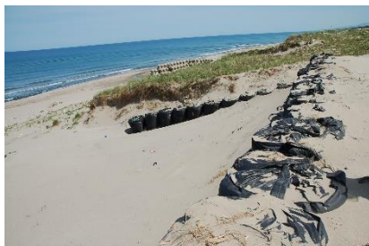
大型土のうの設置
