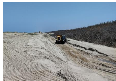
海岸作業道の浚渫
