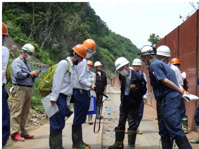
遠隔臨場のデモンストレーション
