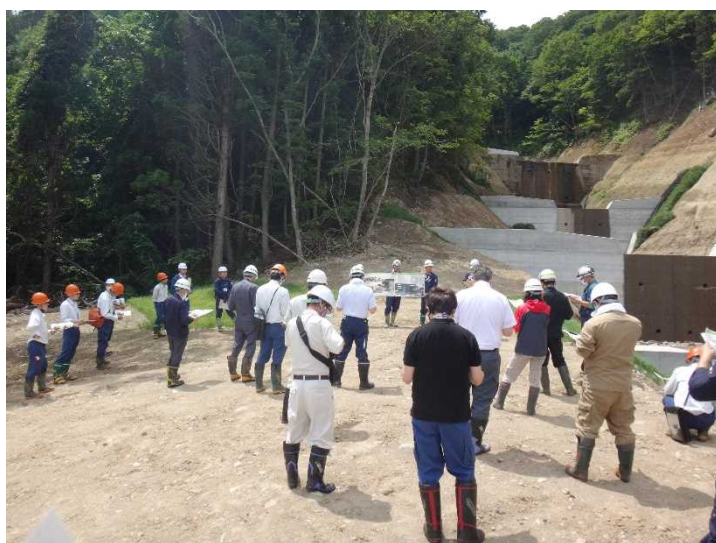
下北地域県民局で施工した溪間工
