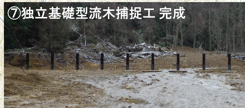
④独立基礎型流木捕捉工 完成
