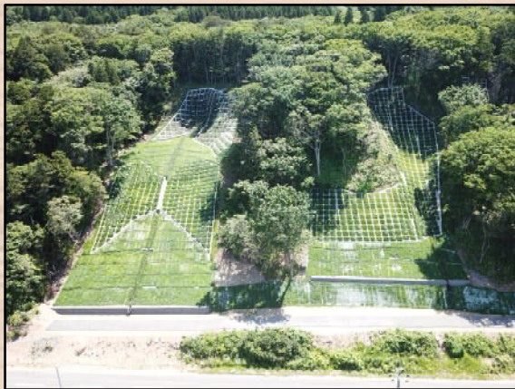
【下風呂地区山腹工】
