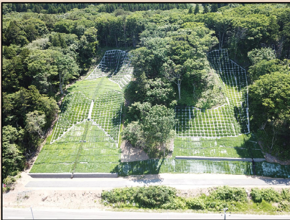
【下風呂地区山腹工】
