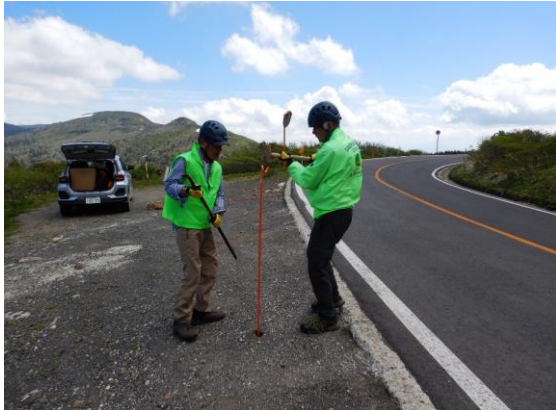
杭を打ったら
