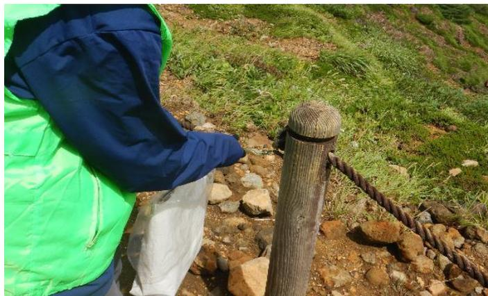
柵のロープが外れていたのを補修します。
