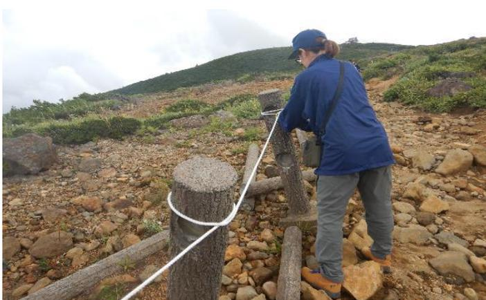
木柵が壊れていたためロープで補修します。
