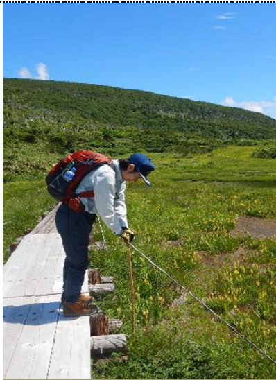
木道沿いのポールを補修しました。
