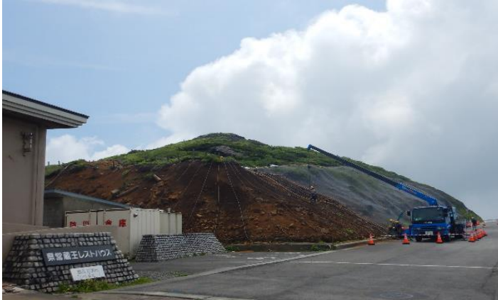
レストハウスにて 法面崩れ防止ネットの工事が行われていました。
