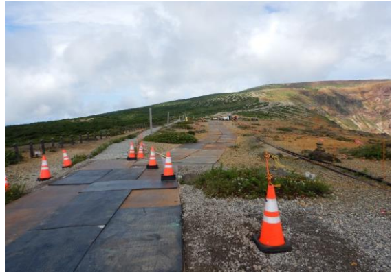
揚水工事が行われていました。
