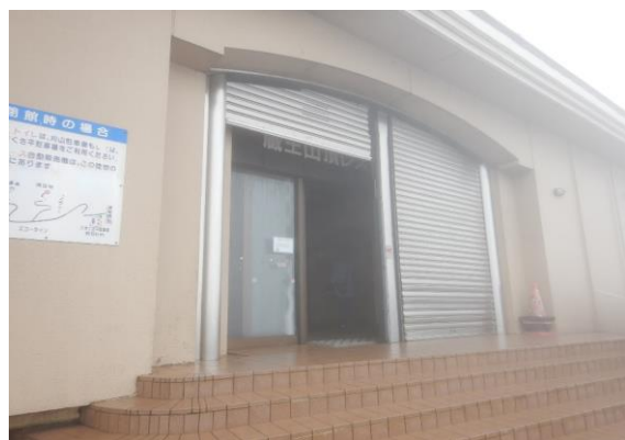
強風のためレストハウス入口のシャッターが下りています。
