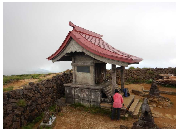
蔵王山神社の屋根の修理が終わりました。
