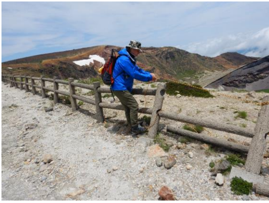
倒れた柵をトラロープで補修中
