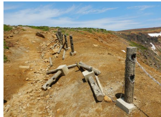
擬木柵が倒れていました。
