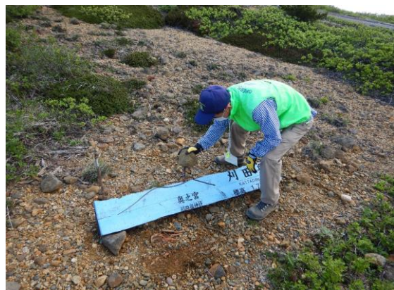
案内板の固定杭も打ち直しました。
