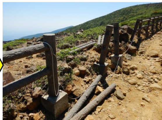
柵をロープで補修します。
