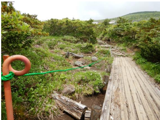
南蔵王縦走路の古いロープを取替えました。
