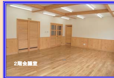
床フローアは無垢の木材を使用し、「木の風合い」を生かしたづくり（事務室・廊下・会議室にナラ材、署長室はクリ材を使用）
