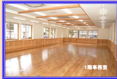
床フローアは無垢の木材を使用し、「木の風合い」を生かしたづくり（事務室・廊下・会議室にナラ材、署長室はクリ材を使用）
