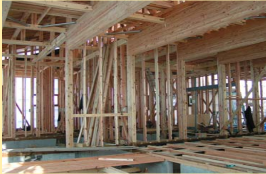
構造材に地域の代表樹種であるスギ・アカマツ・カラマツを使用（1階事務室に南側より）
