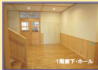
目線に「木の暖かみ」が伝わるようスギの羽目板を使用
