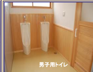
トイレ周りの壁には殺菌力（ヒノキチオール）を含むヒバ材を使用
