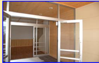
玄関・ホールにはスギ・アカマツの羽目板が木の空間を演出
