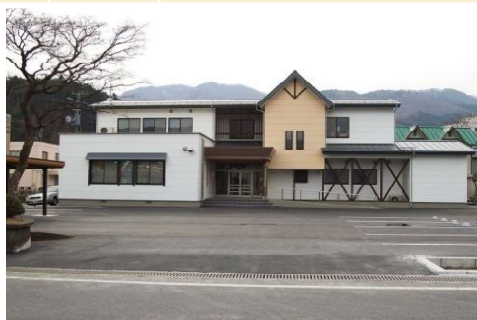
三陸中部森林管理署 庁舎前景(H20.2月完成)
