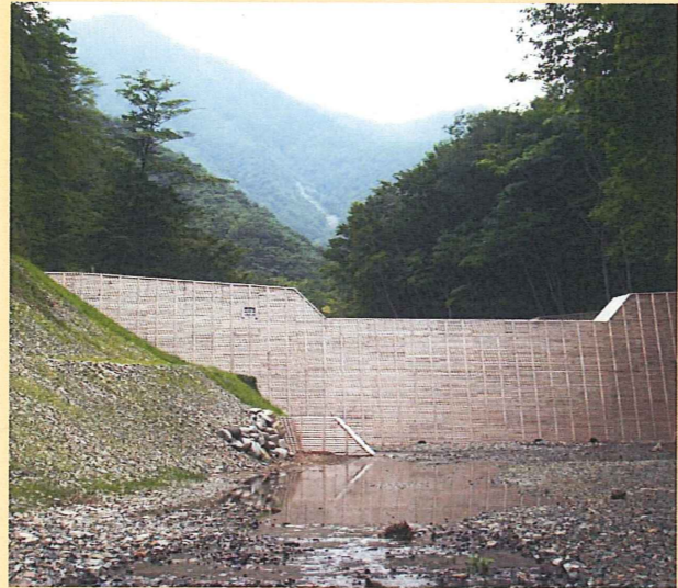
愛染山を背景に堤高が9mともっとも高い治山ダム(H20年完成/表紙写真と同じ)
