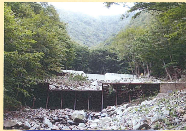
溪流の勾配を緩め、河川の浸食を軽減して、保安林機能を維持する治山ダム(上方がH19年完成)
