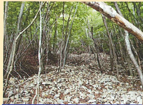
崩壊や浸食により、土砂が上流から流出し堆積した様子
