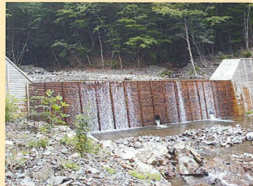
ダムに土砂がたまり、山脚を固定
