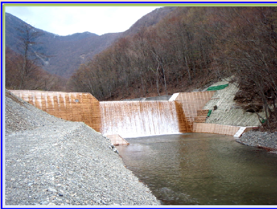
たにどめこう 木製型枠を生かした谷止工の施設(甲子川上流部 枯松沢H20年完成)
