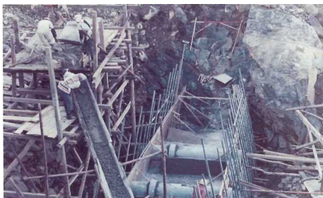
S 4 8 の 石 合 沢 治 山 工 事
