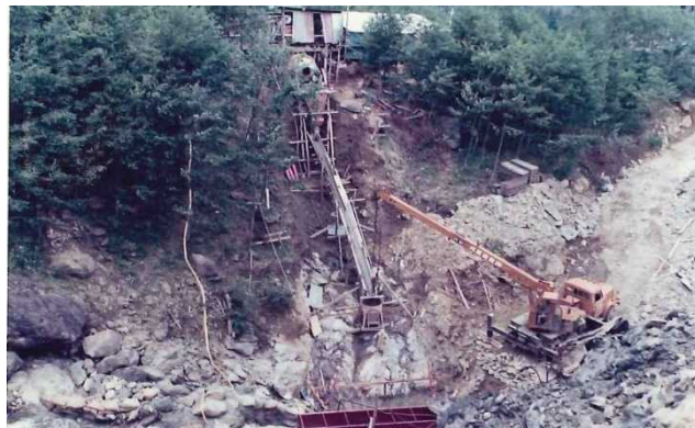
S 4 9 の 石 合 沢 治 山 工 事
