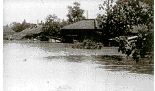
～ 決壊した堤防付近～
