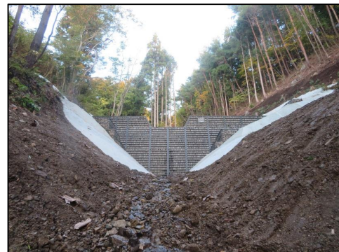
田の浜治山工事 (鋼製柵谷止工)
