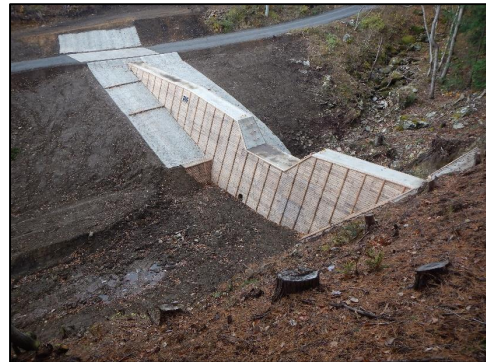
シドケ沢治山工事 (コンクリート谷止工)
