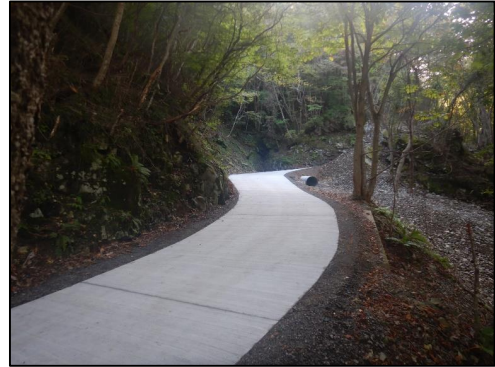
石浜林道改良工事(コンクリート路面工)
