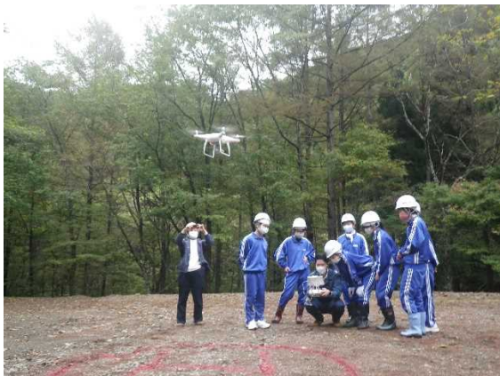
ドローンを飛ばして治山現場を確認！
