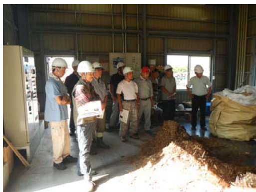
木質バイオマスボイラー
