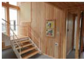
階段（壁材スギ材使用）
