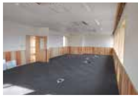
2階 事務室（保全センター）
