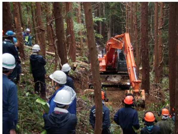
バックホウによる森林作業道作設
