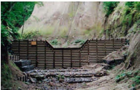
間伐材を活用した木製谷止工（十和田市・平沢）
