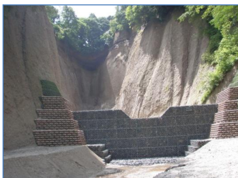
荒廃地に設置した谷止工（十和田市）
