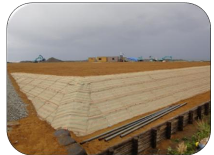
H27 完成した盛土工
