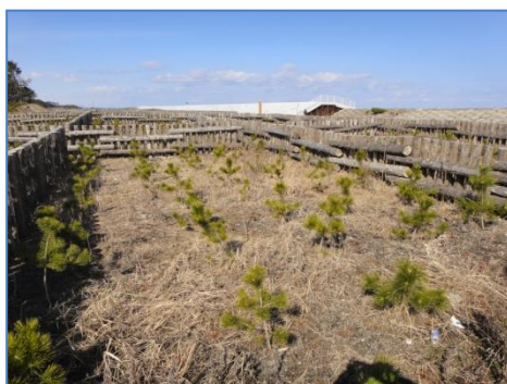
間伐材を利用した防災林復旧工事（三沢市）
