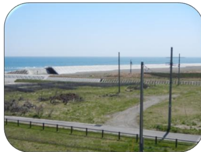
H26 完成した防潮護岸嵩上工
