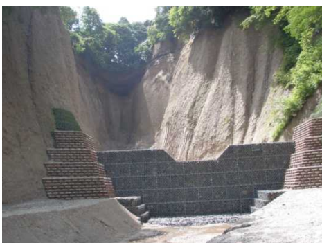
荒廢地に設置した谷止工（十和田市）
