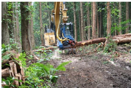
ハーベスタによる間伐材の伐採・造材
