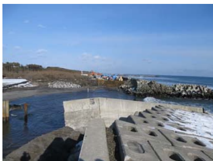
津波災害復旧工事（三沢市）
