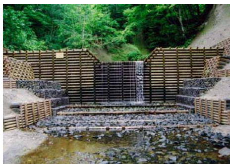
間伐材を活用した木製谷止工（十和田市）
