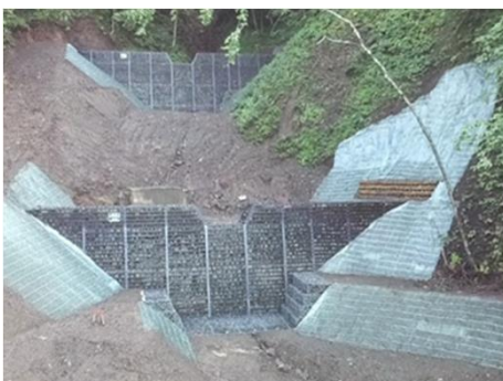
押出沢施設災害復旧治山工事 (鋼製枠) (十和田市)
