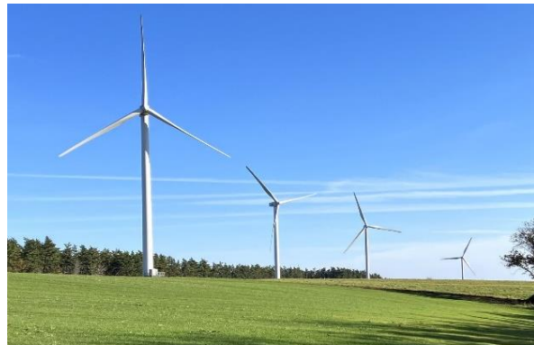
風力発電施設【六ヶ所村】
