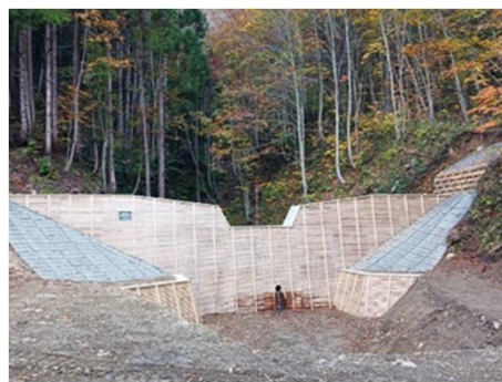
作田川治山工事 (木製残存型枠) (七戸町)
