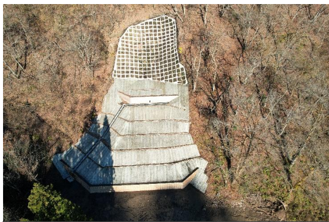
金目地区山腹工
