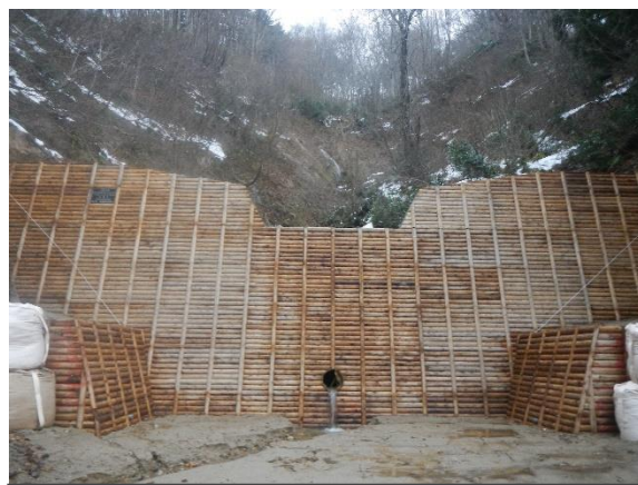
合地沢地区谷止工
