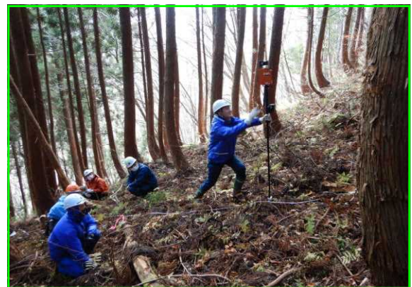
3Dレーザの活用
