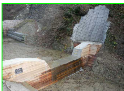
松ノ沢治山工事
