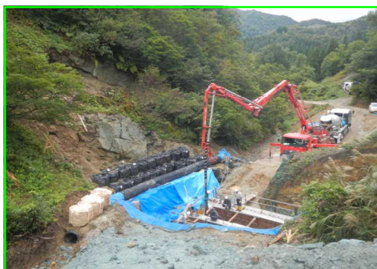
松ノ沢治山工事
