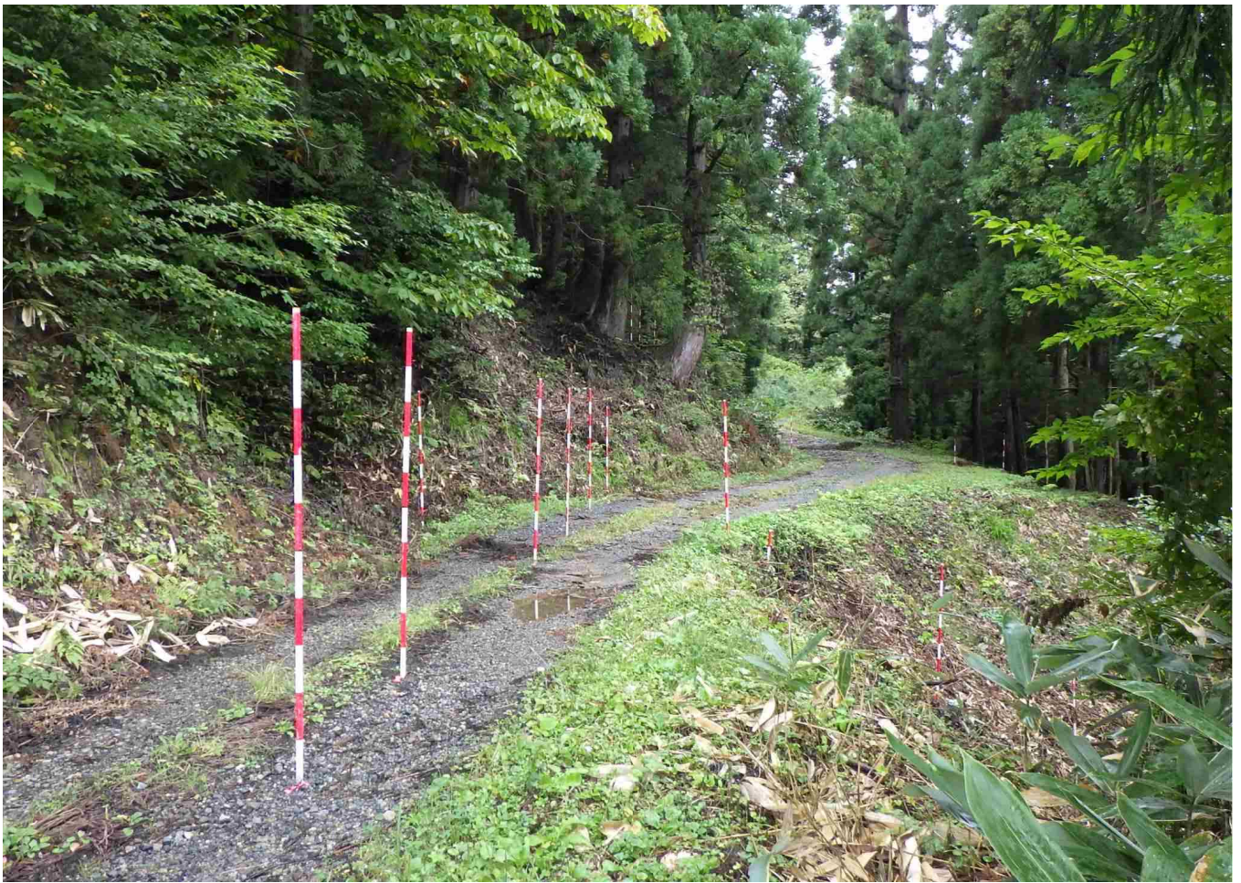
10-3 0.4km 路体崩落 L=62m
