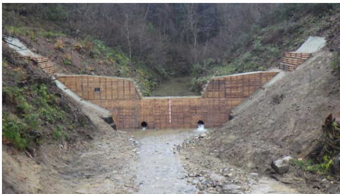
令和7年度_東又沢治山工事 (溪間工_コンクリート谷止工)
