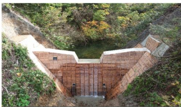
大清水沢地区谷止工
