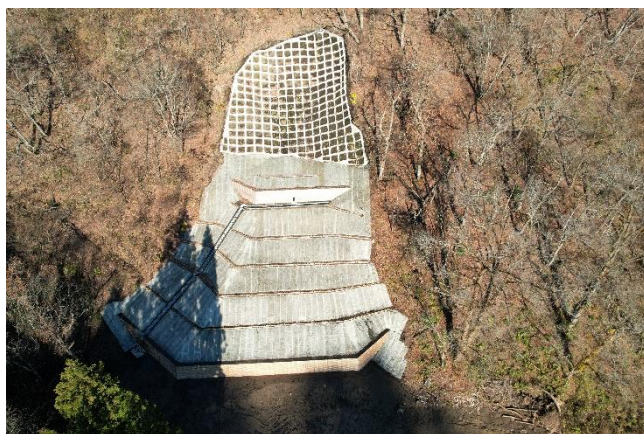
金目地区山腹工
