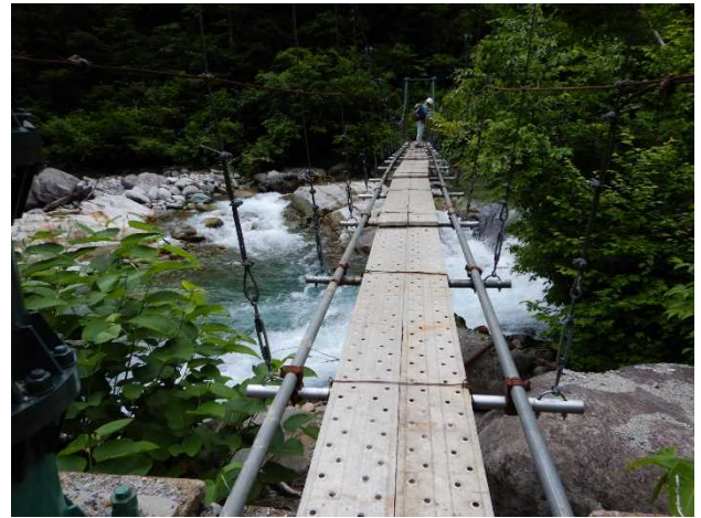
桧山沢出合の吊り橋の確認。
