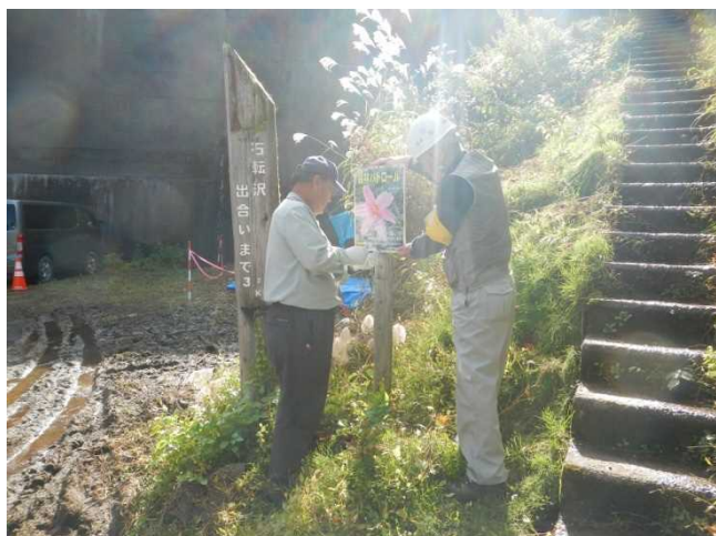
案内板を修繕するスタッフ
