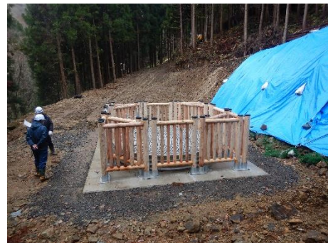
【集水井工（完成）】
