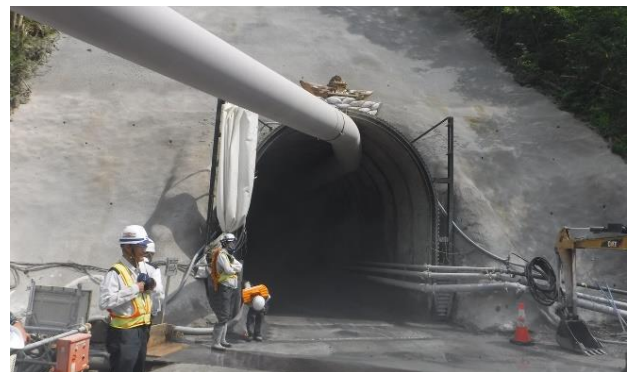
【排水トンネル工（工事中）】
