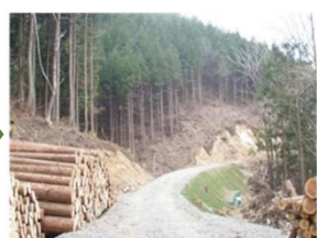
開設された林業専用道
