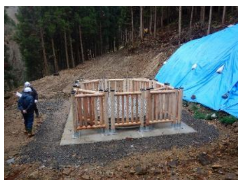
【集水井工（完成）】
