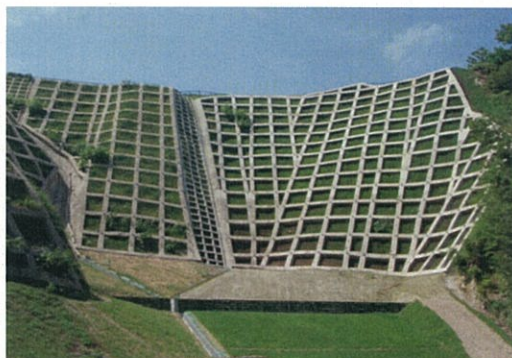
H25年度民直治山施工地
