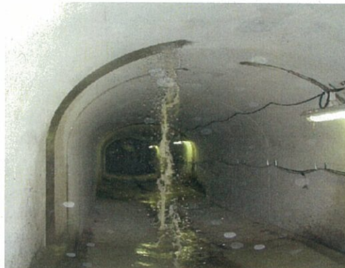
排水トンネル工
