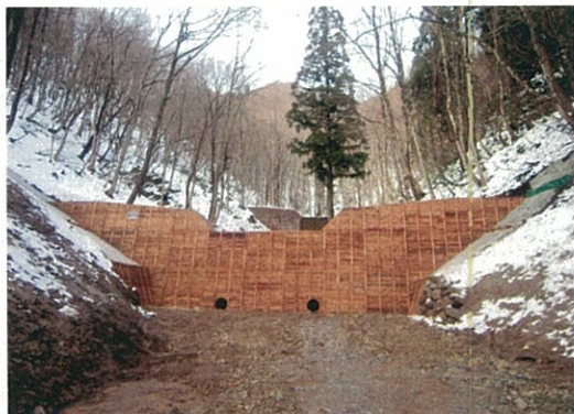
H25年度国直治山施工地
